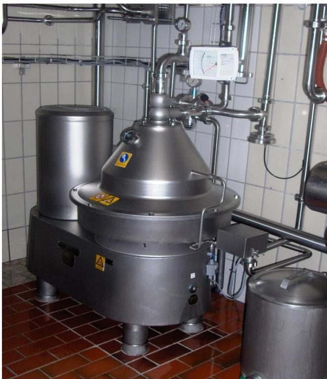
Zur Arbeitserleichterung wurde eine selbstreinigende Zentrifuge installiert. Sie ist erst die zweite dieses Typs die in der Schweiz installiert wurde. Speziell ist der Antrieb, der durch einen Antriebsriemen zwischen Motor und Zentrifuge funktioniert und nicht wie sonst üblich über ein Getriebe. Die Leistung liegt bei 5000 Liter Milch und 7500 Liter Molke in der Stunde.
